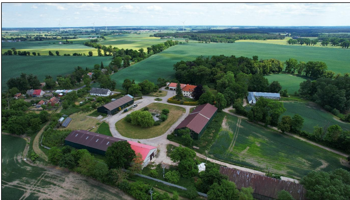
Zdjęcie 15. Watkowice - dwór otoczony zielenią wysoką, budynki nie stanowią dominant wysokościowych i nie są dobrze widoczne
